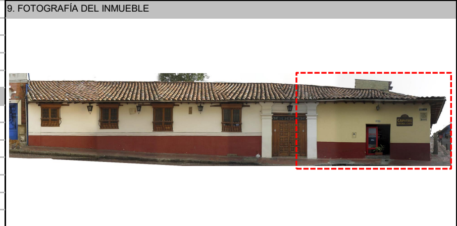
Fuente: Equipo Fotografía PEMP Patrimonio Inmueble
